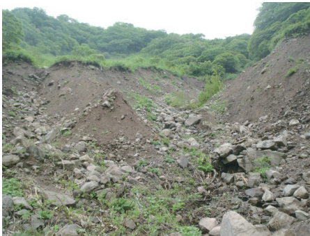
写真1 太谷川上流の山腹崩壊
