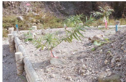
写真9 直挿したオノエヤナギ（写真8の施工地）
