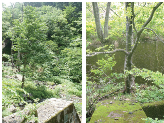
写真4 （左）谷底部（堆砂域）のサワグルミ （右）間詰と袖隠し埋戻部のミズキとケヤキ
